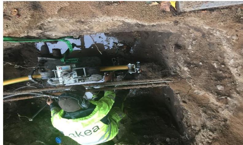
Här förs ett nytt plaströr in i ett gammalt gasrör. Metoden är betydligt billigare än att lägga helt nya gasledningar.
